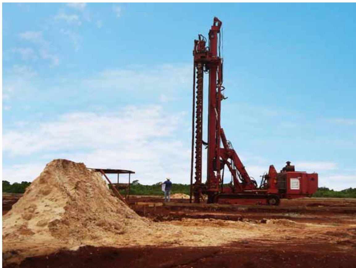
Obras de construção de mais uma escola no assentamento
